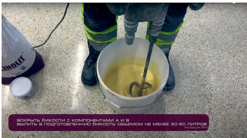
2. Постепенно внести наполнитель (компонент С) в смесь, мешать в течение 1-2 минут до полного перемешивания и получения гомогенной (однородной) смеси. Особое внимание следует уделять тщательному перемешиванию материала в зоне дна и стенок ведра во избежании дефектов покрытия (плохо перемешанные компоненты и комки сухой смеси не полностью вступают в химическую реакцию).
